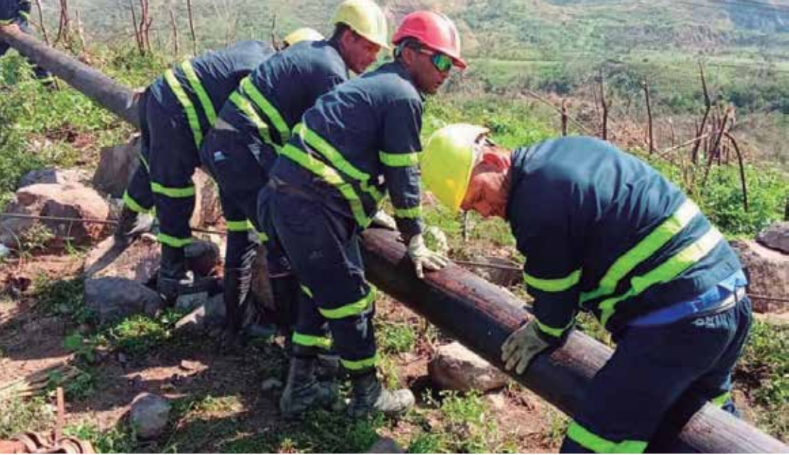
El trabajo es intenso para que llegue la electricidad en el menor tiempo posible. /Foto: Cortesía de la Empresa Eléctrica
