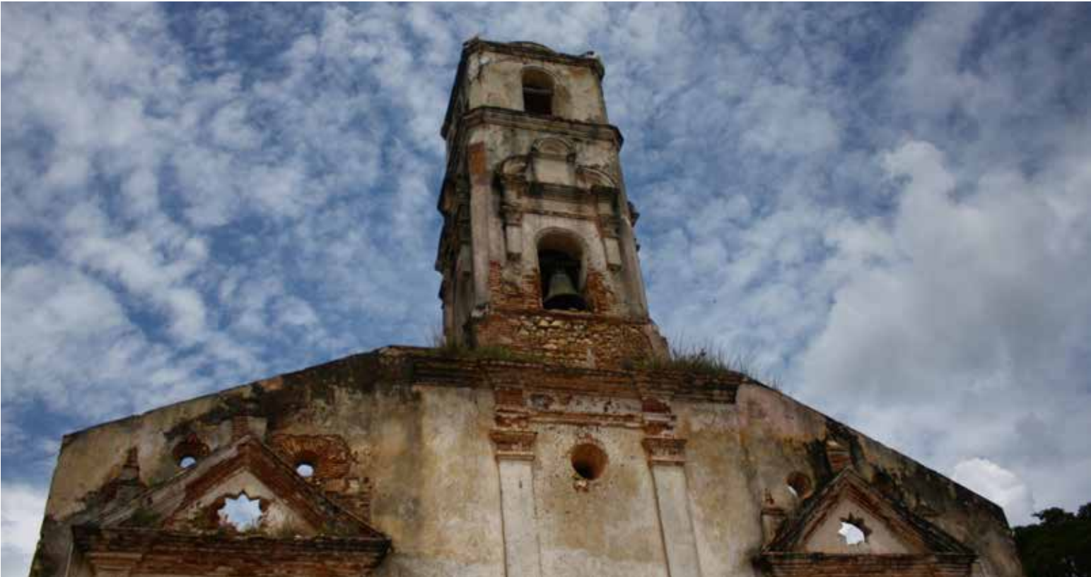
La iglesia “abandonada” de Santa Ana se encuentra en una de las arterias principales de Trinidad. /Fotos: Roberto Javier Bermúdez
