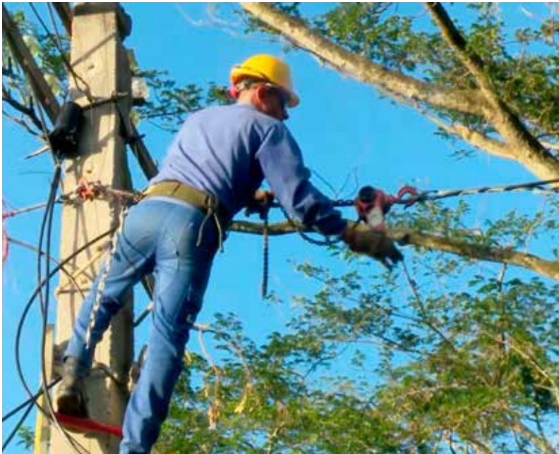
Los telecomunicadores espirituanos recuperan en lo posible, sobre el terreno, los elementos dañados para su posterior reutilización.
