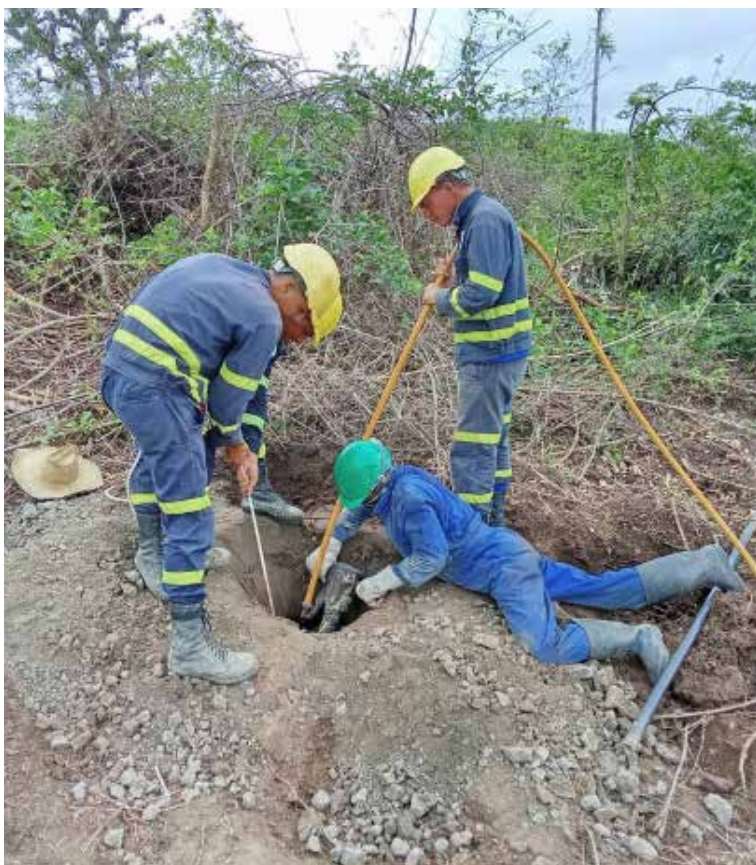
El contingente realizó labores de cambio de postes, muchos de ellos a mano.
