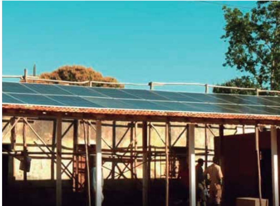
Las labores avanzan en la emblemática edificación de Manaca Iznaga.
