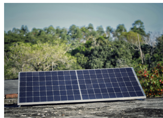
La instalación de módulos fotovoltaicos para niños con necesidades especiales se extiende al Plan Turquino fomentense.
