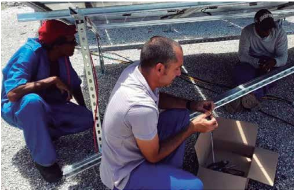
Los propios trabajadores de RadioCuba ejecutaron la instalación. /Foto: Cortesía de la empresa
