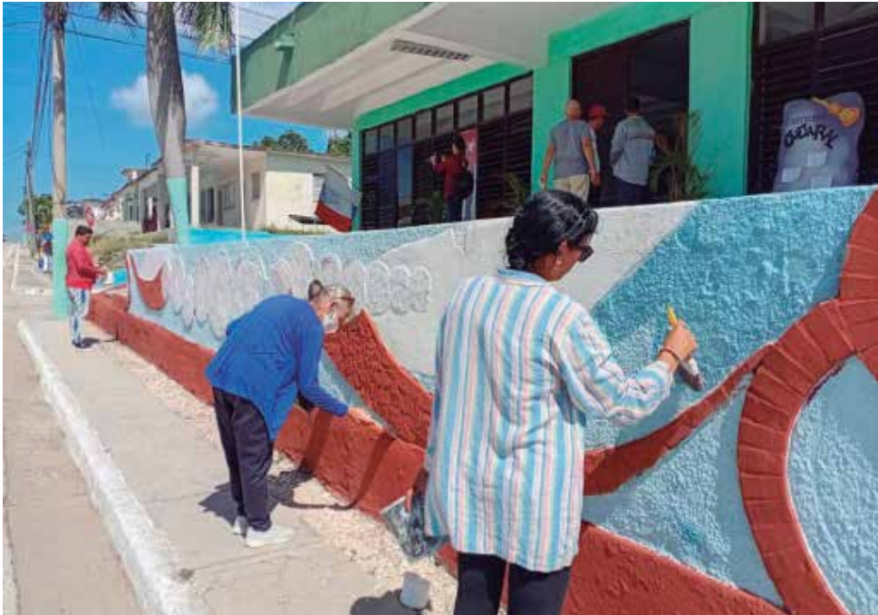
Diversas acciones de mantenimiento y pintura se han llevado a cabo en el municipio en el contexto de la celebración.
