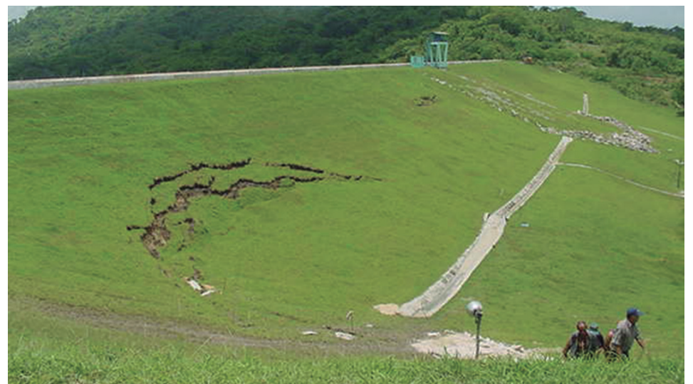
Mientras duró la reparación de la cortina de la presa, Cuba entera se mantuvo en vilo. /Foto: Vicente Brito
